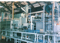
ローラーチェーン部品の硝酸化熱処理設備
